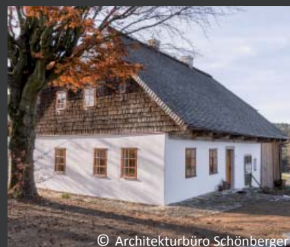
Waldlerhaus in Stadlern; eines der letzten für die Region Bayerischer und Oberpfälzer Wald typischen Bauernhäuser; Sanierung mit Denkmalpreis ausgezeichnet; Fensterverglasung bestehend aus restauro®ISO mit restauro®leicht 3mm im Aufbau 3-4-3; Einbau 2016
