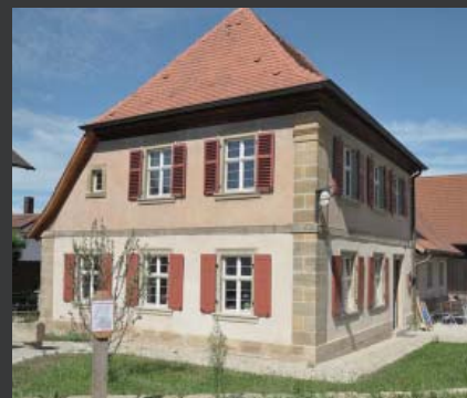
historisches Gebäude aus dem 18. und 19. Jahrhundert in Scheßlitz b. Bamberg; restauro®ISO mit restauro®stark 3mm im Aufbau 3-10-3; Einbau 2012
