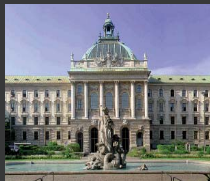
Justizpalast München, Verwaltungs- und Gerichtsgebäude; erbaut Ende des 19. Jh.; restauro®ISO mit restauro® leicht 3mm; Einbau 2013/2014
