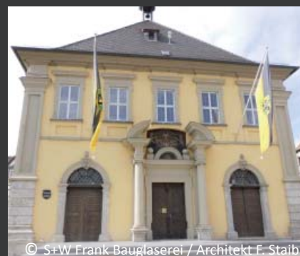
Rathaus Eibelstadt bei Würzburg; restauro®ISO mit restauro®leicht 3mm im Aufbau 3-4-4 mit von außen aufgeklebten Bleisprossen; Einbau 2016/2017
